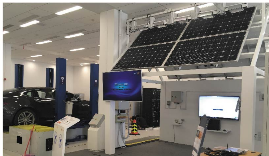
电气技术与装备实训平台
