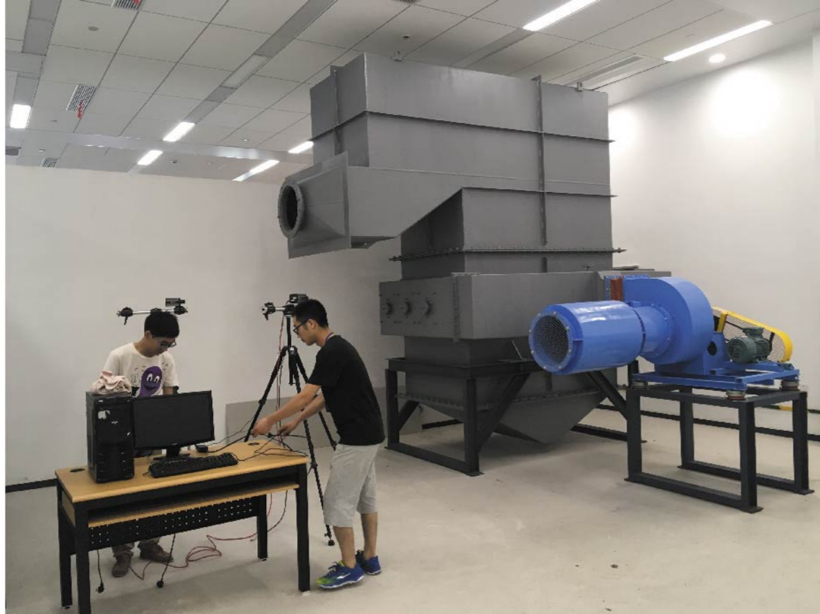
高效清洁低碳能源实训平台
