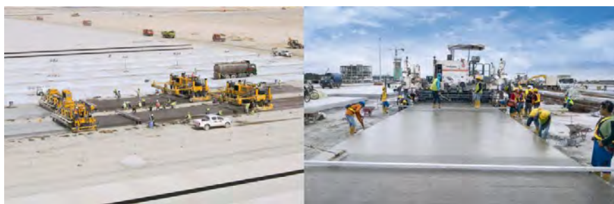
图 1 滑模摊铺技术及其施工场景
